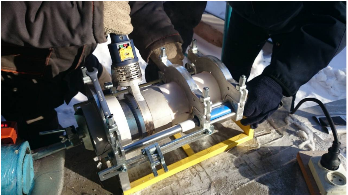
Рисунок 2.34 - Нагревание (оплавление) внутренней поверхности муфты и внешней поверхности трубы с помощью насадок для сварки
