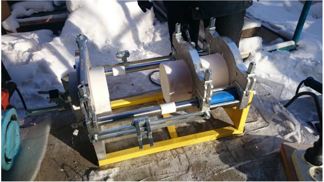
Рисунок 2.33 - Свободное охлаждение муфты и трубы для выравнивания температур (2 минуты)
